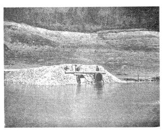
Abb. 14. Lungernseewerk. IV. Ausbau. Das fertige Auslauf-Bauwerk der beiden Leerlaufleitungen bei Kaiserstuhl.
