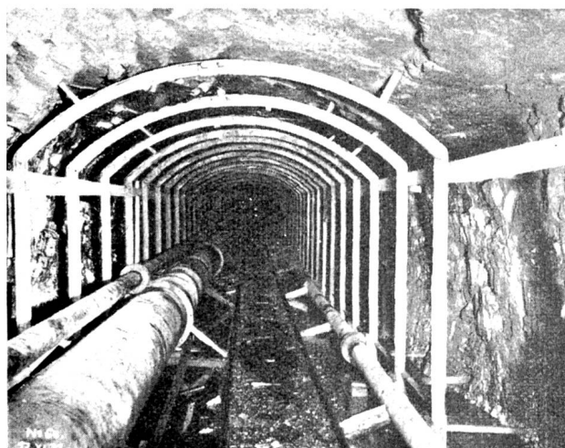
Abb. 12. Lungernseewerk. IV. Ausbau. Großmelchaa-Stollen. Eiserne Lehrgerüste für die Stollenbetonierung. Links Ventilationsleitung, Druckluftleitung und Kabel. Rechts Pumpwasserleitung.
