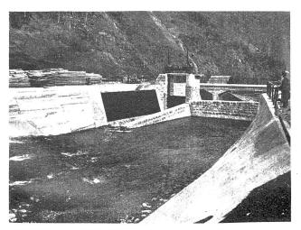
Abb. 3. Lungernseewerk IV. Ausbau. Großmelchaa-Stollen. Wasserfassung an der Großen Melchaa, flußabwärts gesehen. Links Einlauf und Grundablaß, rechts Überfallwehr, im Hintergrund die neue Melchaa-Brücke.
