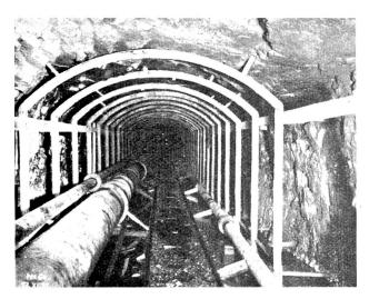
Abb. 12. Lungernseewerk. IV. Ausbau. Großmelchaa-Stollen. Eiserne Lehrgerüste für die Stollenbetonieruug Links Ventilationsleitung, Druckluftleitung und Kabel. Rechts Pumpwasserleitung.
