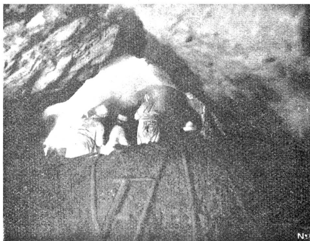
Abb. 13. Lungernseewerk. IV. Ausbau. Großmelchaa-Stollen. „Vor Ort“ mit zwei pneumatischen Bohrhämmern.
