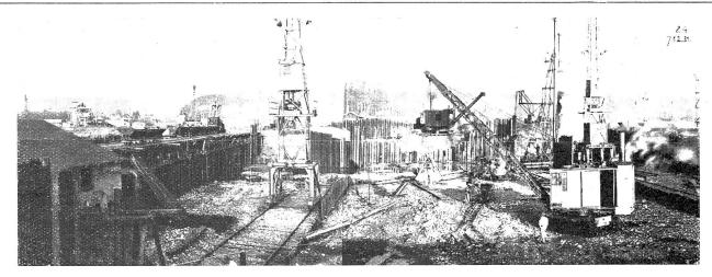
Abb. 5. Kraftwerk Klingnau, Wehrbaugrube im Stadium der Aushubarbeiten.
