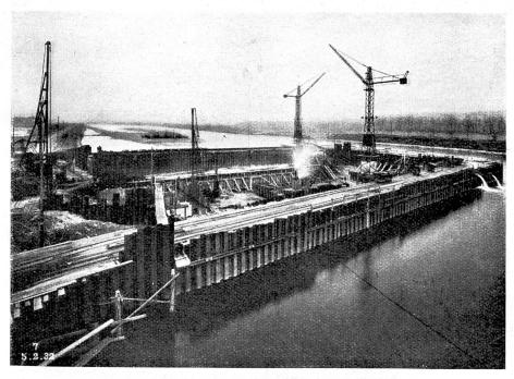
Abb. 9. Kraftwerk Klingnau. Wehrbaugrube.
