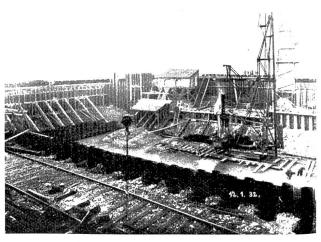
Abb. 7. Kraftwerk Klingnau. Wehrbaugrube im Stadium der Aushubarbeiten.
