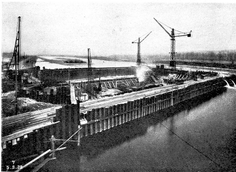
Abb. 9. Kraftwerk Klingnau. Wehrbaugrube.
