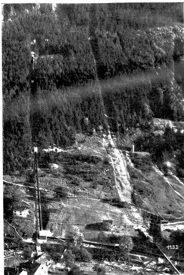
Abb. 7. Kraftwerk Sernf-Niederenbach-Druckleitungen.
