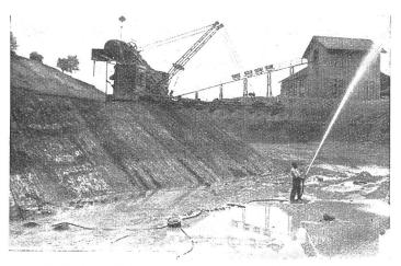
Elektrische Schwimmpumpe im Betrieb in einem Dachziegelwerk.
