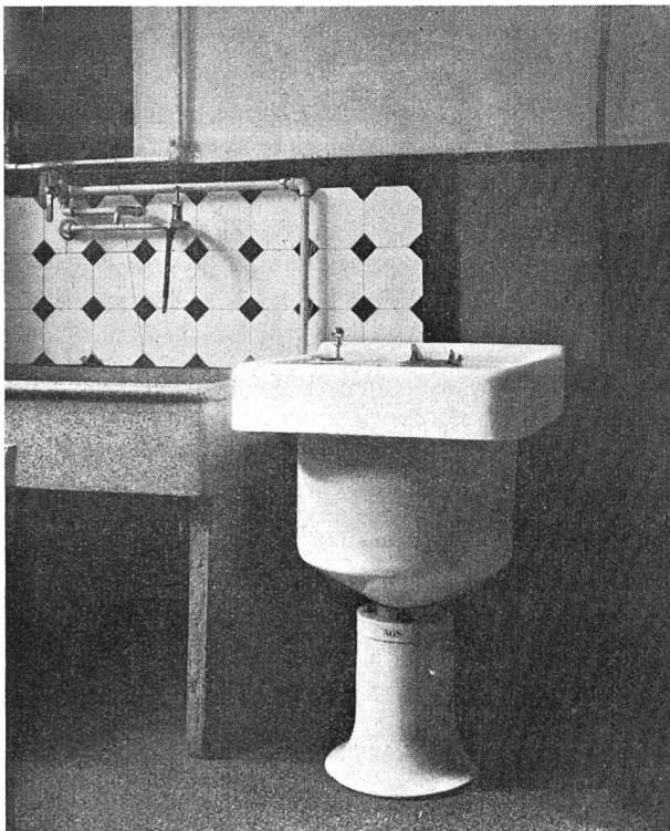
Abb. 23 «SOS» Geschirrwashmaschine mit Anschluss an Boiler.
