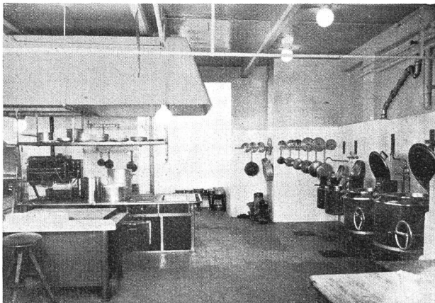
Abb. 21 Die elektrische Küche im Kornhauskeller in Bern.
