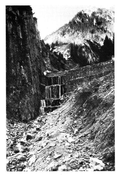
Abb. 16. Mustrigilbach in Montavon, Vorarlberg — Sperrenserie in Zementmörtel-Mauerwerk zwecks ausgiebiger Sohlenhebung
