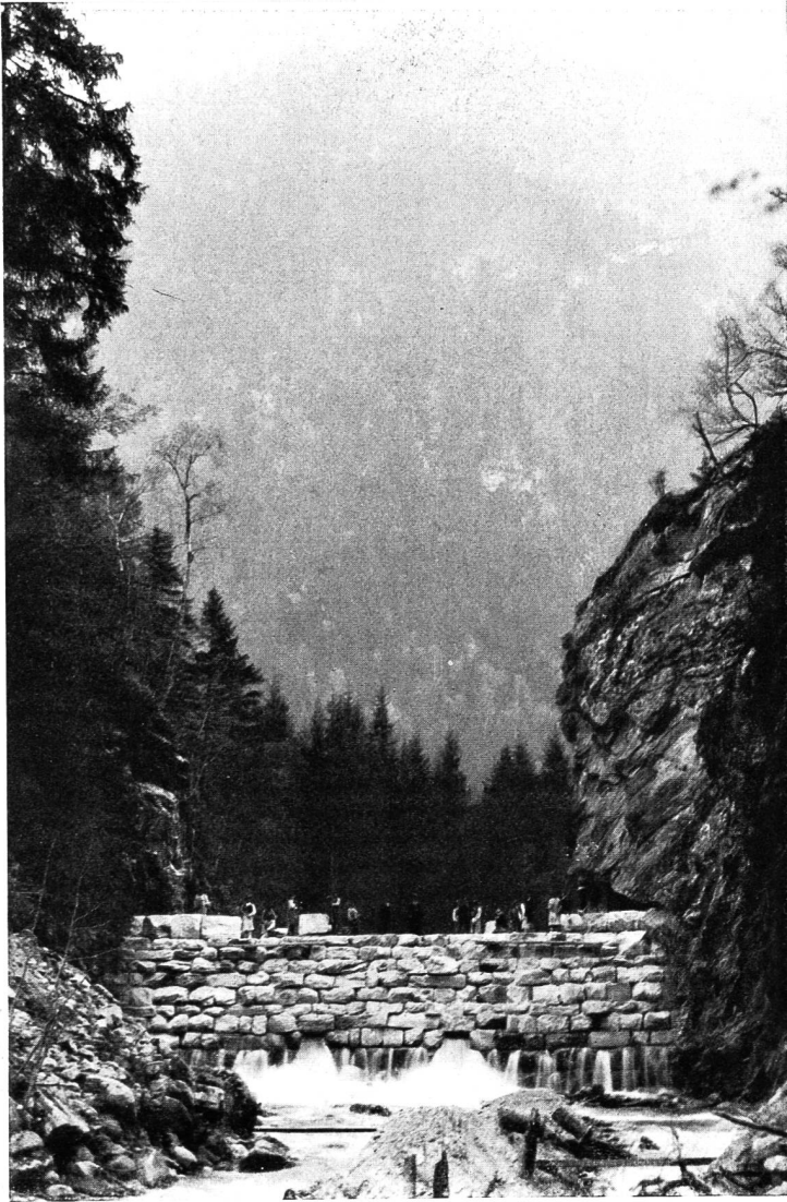
Abb. 3. Obersulzbach in Pinzgau, Salzburg — Stausperre in Trockenmauerwerk während des Baues
