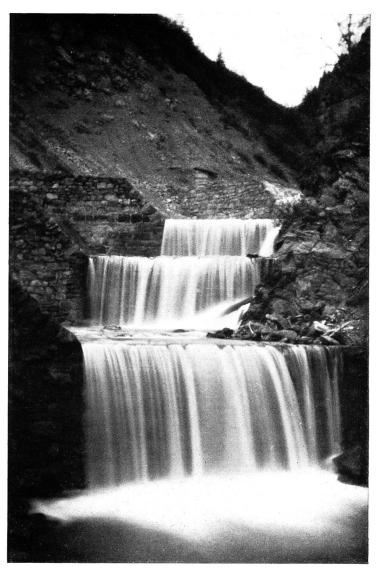
Abb. 21. Rellsbach in Montavon, Vorarlberg — Abtreppung mit Steinsperren
