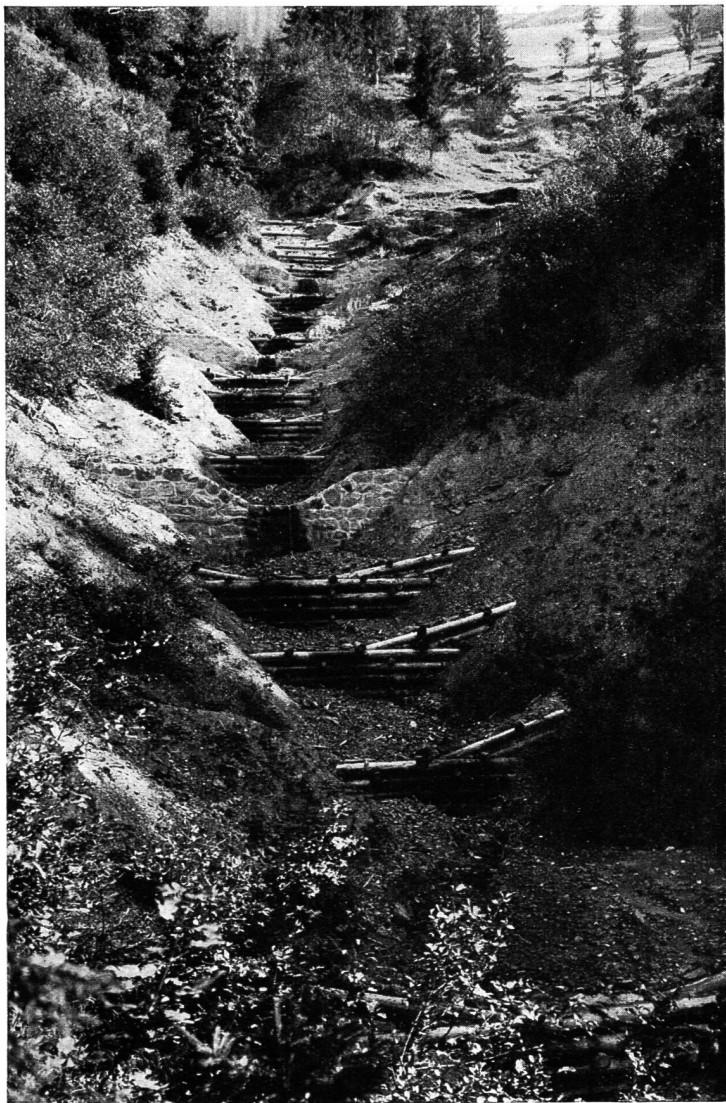
Abb. 11. Meßnergraben bei Hopfgarten, Nordtirol — Abtreppung mittelst Stein- und Holzsperrn
