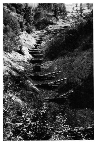
Abb. 11. Meßnergraben bei Hopfgarten, Nordtirol — Abtreppung mittelst Stein= und Holzsperren
