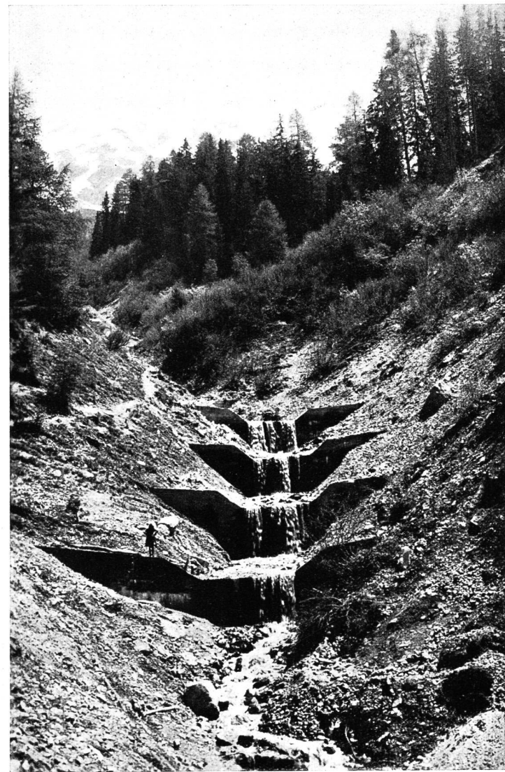
Abb. 12. Fendler Muhre bei Ried, Nordtirol — Abtreppung mit Steinsperren
