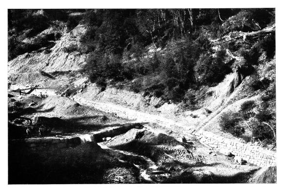
Abb. 27. Siflitzgraben in Oberkärnten — Durch Grundschwellen gesicherte Lehnenfußversicherung, im Bau begriffen
