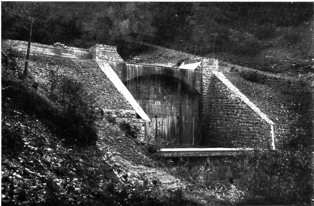
Abb. 24. Steinebach bei Dornbirn, Vorarlberg. — Eisenbetonsperre mit Gegensperre und gewölbter Schußtenne. Widerlager in Zementmörtel-Mauerung. Überfallskanten mit Eisenbahnschienen armiert. (Vorbau vor einer alten, baufälligen Holzsperr.)
