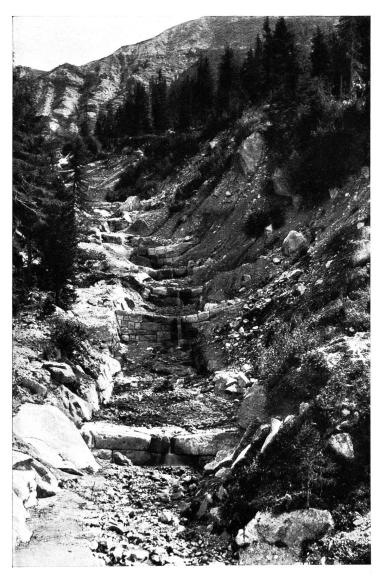
Abb. 13. Naifbach bei Meran, Südtirol — Runsenverbauung mittelst gemauerten Querz und Längsbauten
