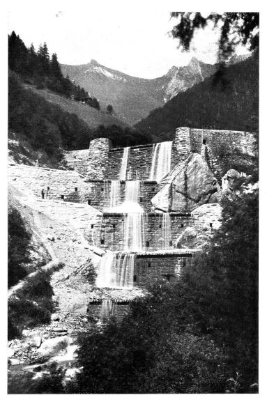
Abb. 15. Bretterwandbach bei Matrei in Osttirol — Sperrenserie am Falkenstein. Sperren in Zementmörtelmauerung.
