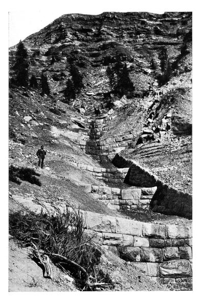
Abb. 14. Naifbach bei Meran, Südtirol — Runsenverbauung mittelst gemauerten Querz und Längsbauten
