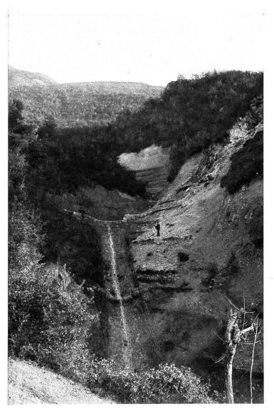
Abb. 17. Rivo Sornell bei Lavis, Südtirol — Schalenbau zur Sicherung einer steilen Grabenpartie gegen Erosion
