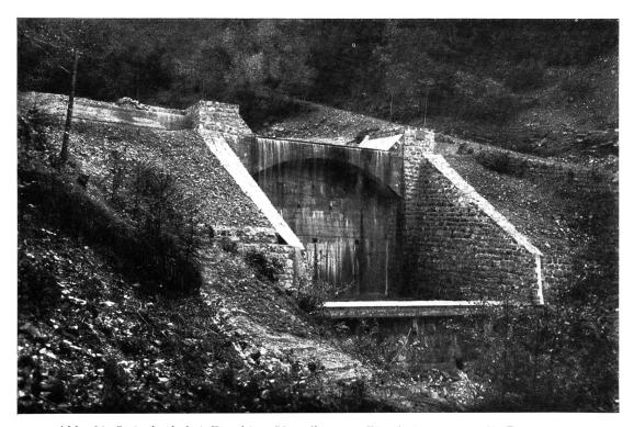
Abb. 24. Steinebach bei Dornbirn, Vorarlberg. — Eisenbetonsperre mit Gegensperre und gewölbter Schußtenne. Widerlager in ZementmörtelzMauerung. Überfallskanten mit Eisenbahnschienen armiert. (Vorbau vor einer alten, baufälligen Holzsperre.)
