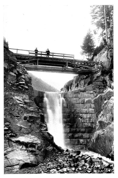
Abb. 5. Rivo Brusago, Cembratal, Südtirol — Stausperre in Zementmörtel-Mauerwerk
