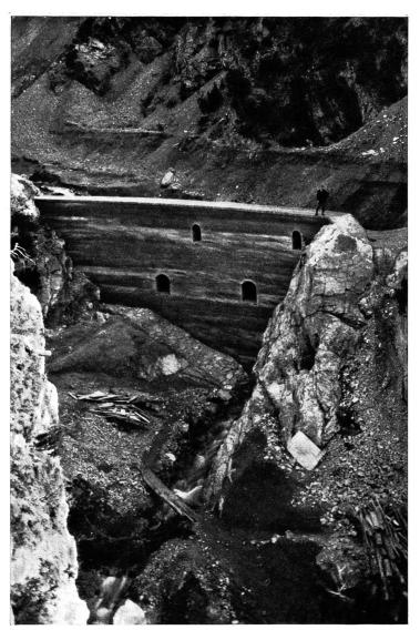
Abb. 7. Schloßbach bei Zirl, Nordtirol — Sperre in Stampfbeton mit Abflußgerinne im Fels am linken Ufer
