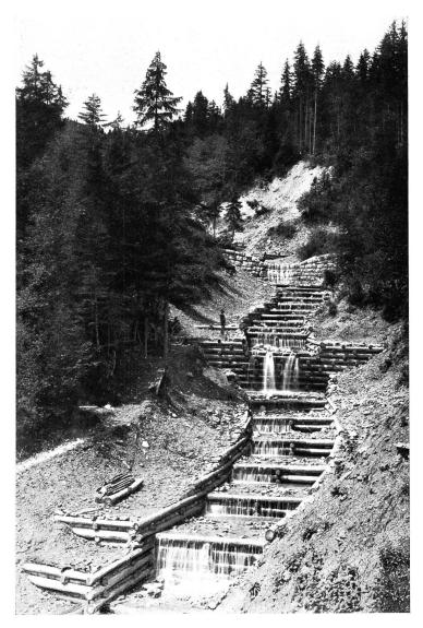
Abb. 10. Glaselbach in Gosau, Oberösterr. — Grabenabtrep» pung mittelst gemauerten Steinkastensperren und einwandigen Holzschwellen in Verbindung mit hölzernen Uferschutzbauten
