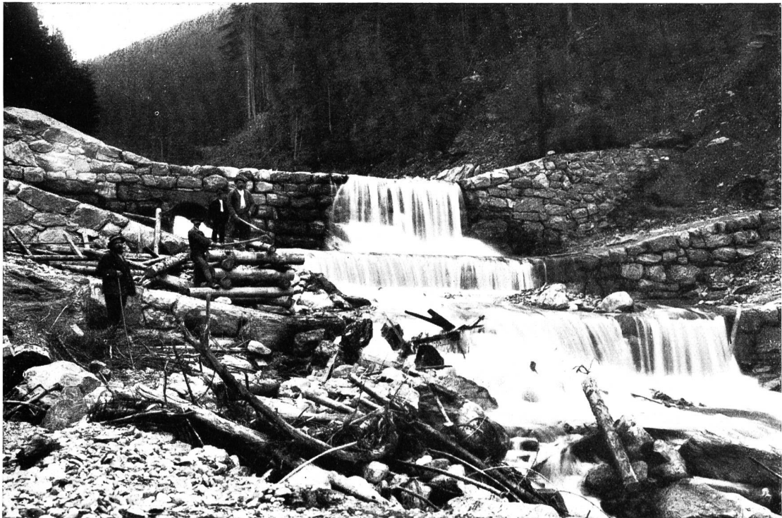
Abb. 23. Märzenbach, Zillertal, Nordtirol — Konsolidierungssperre mit zwei Vorsperren
