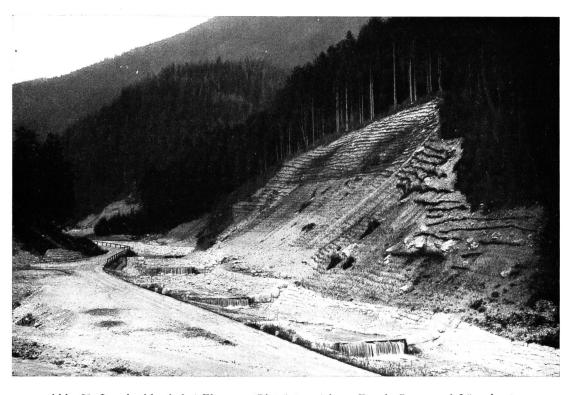
Abb. 28. Langbathbach bei Ebensee, Oberösterreich — Durch Querz und Längsbauten gesicherte Bachstrecke, Bruchfläche bepflanzt
