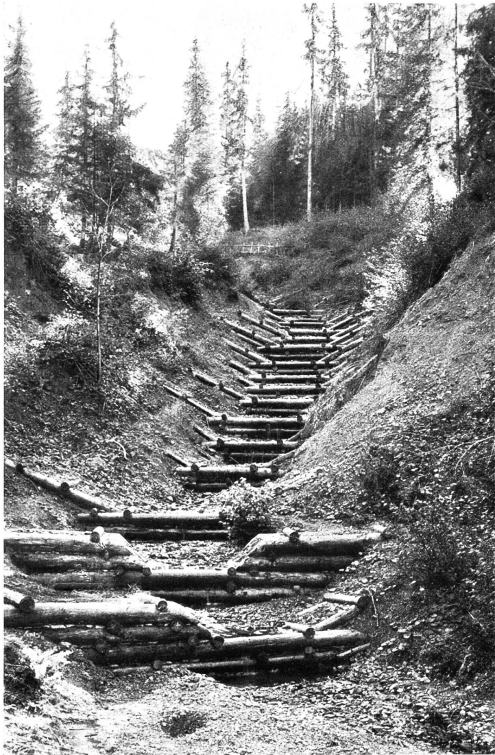
Abb. 9. Klempferergraben bei St. Johann in Tirol — Abtreppung mit niedrigen hölzernen Grundswellen
