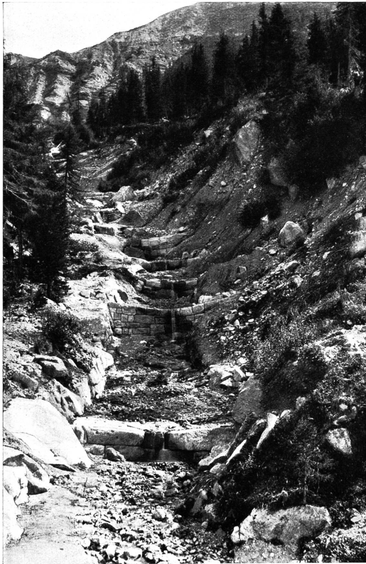
Abb. 13. Naibach bei Meran, Südtirol — Runsenverbauung mittelt gemauerten Quer- und Längsbauten
