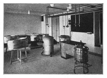
Abb. 4. Die Waschlehrklasse: im Hintergrund die Trockenschleudermaschine, in der Mitte eine elektrisch beheizte Haushaltwaschmaschine, vorn ein motorisch betriebener Sprudelwäscher.
