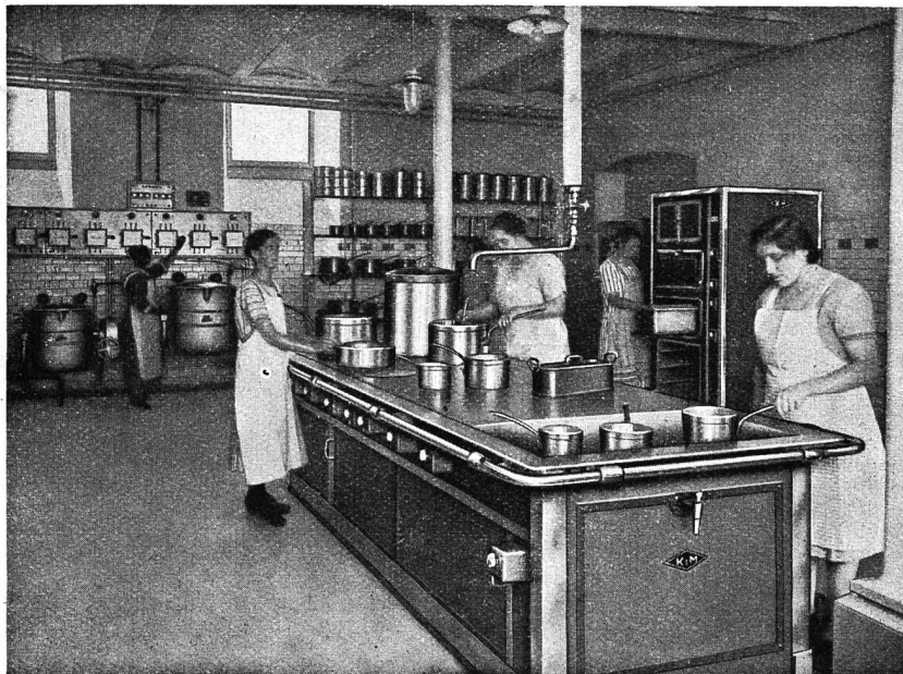
Abb. 1. Elektrische Großküche im Krankenhaus Liestal mit einem Anschlußwert von 83,7 kW.
