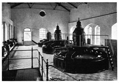
Abb. 8. Kraftwerk Wynau I. Blick in den umgebauten Teil des Maschinenhauses; im Vordergrund die zwei neuen Kaplanturbinengruppen.
