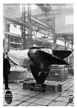
Abb. 6 und 7. Kraftwerk Wynau I. Leitapparat und Laufrad der Kaplanturbine.
