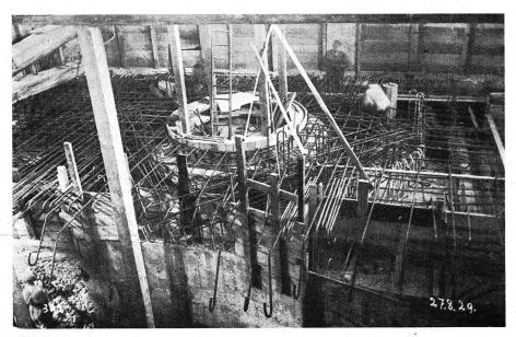
Abb. 5. Kraftwerk Wynau I. Armierung der Fundamente.
