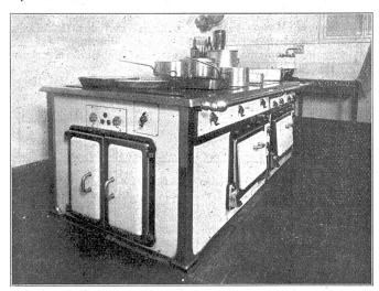
Fig. 1. Elektrische Küche im Restaurant Kappelerhof, Zürich. Ansicht des Herdes mit Wärmeschrank und Backöfen.
