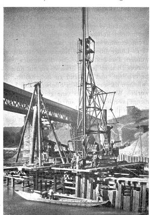
Abb. 5. Kraftwerk Wettingen. Stauwehr, Bohrmaschine und Dampframme.
