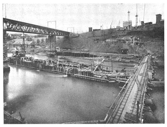
Abb. 6, Kraftwerk Wettingen. Stauwehr und Maschinenhaus. Fuqdation des mittleren Wehrpfeilers, Mauerung der Nordwand des Maschinenhauses und Bau der Betonieranlage.
