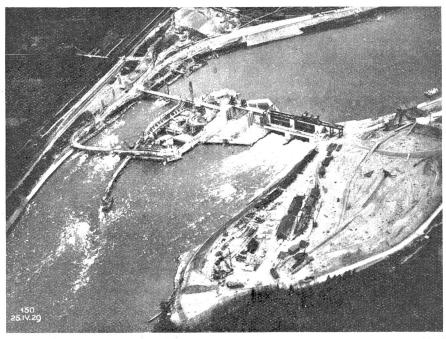
Abb. 2. Erste zwei Wehröffnungen fertig, anschließend Baugrube für linke Maschinenhaushälfte.
