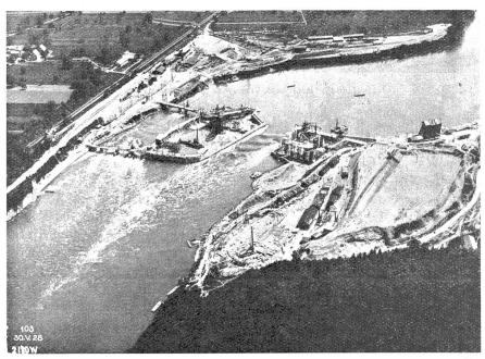
Abb. 1. Ansicht der Baustelle mit Baugrube für erste Wehrhälfte, Baugrube im Fluß für linke Kraftwerkhälfte.
