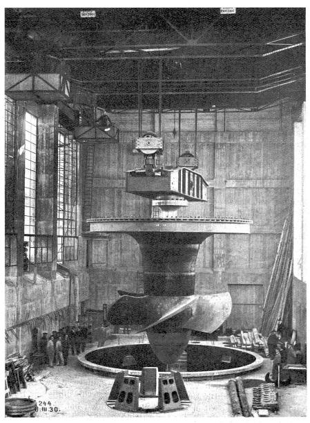
Abb. 7. Fertig zusammengestelltes Laufrad der Kaplanturbine No. 1.
