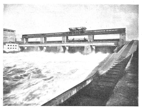
Abb. 6. Wehr mit Ueberfall über die abgesenkten Schützen.
