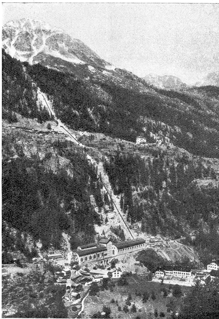
Abb. 7. Kraftwerk Barberine. Zentrale in Chatelard mit Teilstück der Druckleitung.
