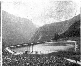
Abb. 6. Kraftwerk Vernayaz. Ausgleichbecken in Les Marécottes, nutzbarer Inhalt 47,000 m8.
