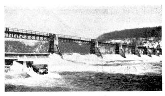
Abb. 47. Links die Wehrschleuse 8 bei entfernten Stauladen überflutend. Rechts davon die stark vereisten Wehrschleusen.
