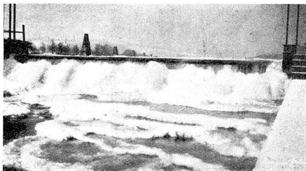
Abb. 46. Kraftwerk Rheinfelden. Die Flossgasse-Schleuse und die Flossgasse sind vereist.
