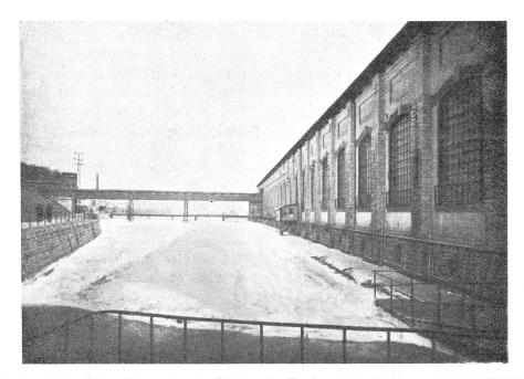
Abb. 44. Kraftwerk Rheinfelden, Die zunehmende Vereisung des Kanals und des Turbinenrechens hat die Stillegung des Betriebes zur Folge
