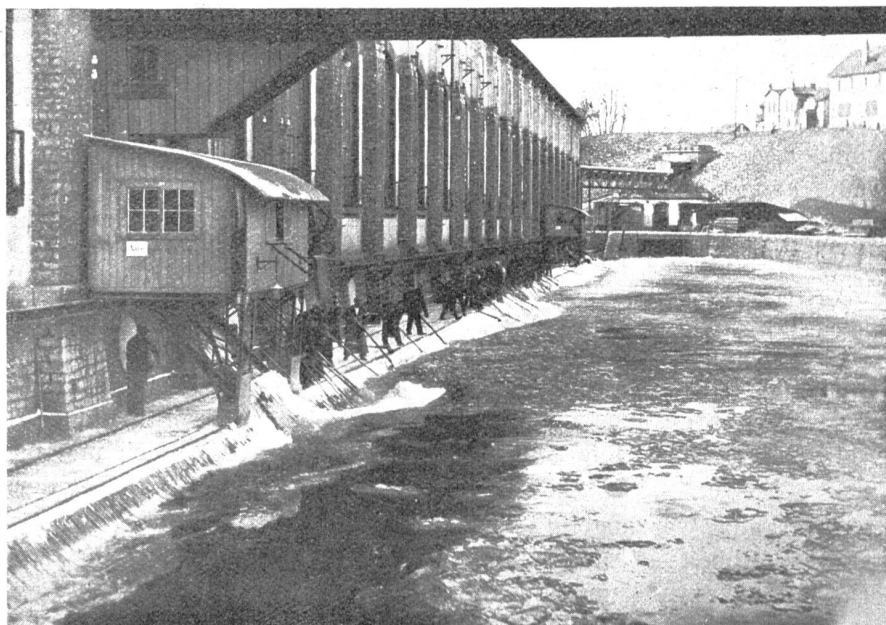
Abb. 42. Kraftwerk Rheinfelden. Rechenreinigungsmaschine und Arbeiten für die Eisabwehr, 12. Februar 1929.
