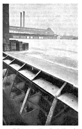
Abb. 54. Kraftwerke Augst-Wyhlen. Stauwehrschützen und Oberwasser. 12. Februar 1929.
