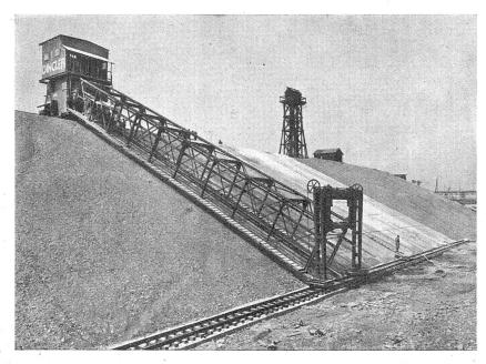
Abb. 9. Installation zur Betonierung der Kanalböschungen.
