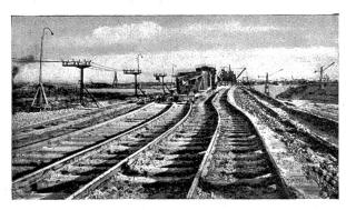
Abb. 6. Die Geleiserückmaschine an der Arbeit.
