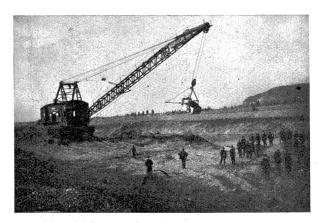
Abb. 5. Amerikanischer Löffelbagger (Dragline) beim Kanalaushub.
