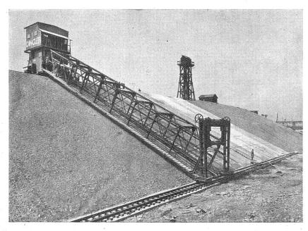
Abb. 9. Installation zur Betonierung der Kanalböschungen.
