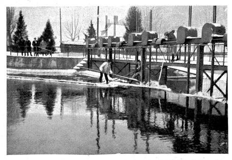
Abb. 26. Elektrizitätswerk der Stadt Aarau. Das Eis wird durch den Ueberlaufkanal II abgeschoben.
