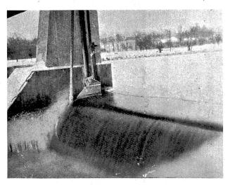
Abb. 31. Kraftwerk Rüchlig. Stauwehr, Oeffnung 1 links, von unten gesehen, Wassermenge in der Aare =  $100~\rm{m^3/sek}$ . Der Ueberfall entsteht periodisch durch die Schwankungen, verursacht durch die oben liegenden Werke. 18. Februar 1920.
