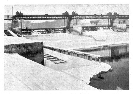
${\rm Abb,\ 22.\ Elektrizit\"{a}tswerk\ der\ Stadt\ Aarau.}$  Freimachen der Stauwehrschleusen von Eis. Grundwasser unterhalb der Schleuse + 5 Grad C.
