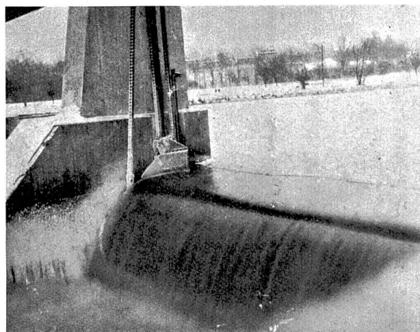
Abb. 31. Kraftwerk Rüchlig. Stauwehr, Öffnung 1 links, von unten gesehen. Wassermenge in der Aare = 100 \text{ m}^3/\text{sek} . Der Ueberfall entsteht periodisch durch die Schwankungen, verursacht durch die oben liegenden Werke. 18. Februar 1929.
