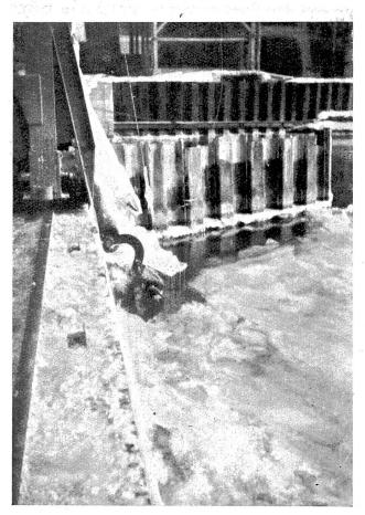
Abb. 29. Kraftwerk Rüchlig. Rechenputzmaschine vor Turbine 2.
