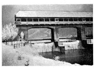
Abb. 15. Elektrizitätswerk Olten-Aarburg, Kraftwerk Gösgen, Vereiste Wehrschützen auf der Unterwasserseite.
