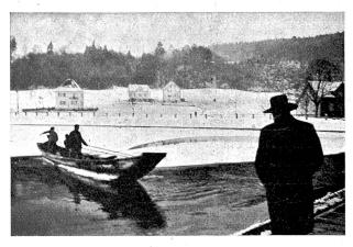
Abb. 18. Elektrizitätswerk Olten-Aarburg, Kraftwerk Gösgen. Brechen der Eisdecke im Oberwasserkana.
