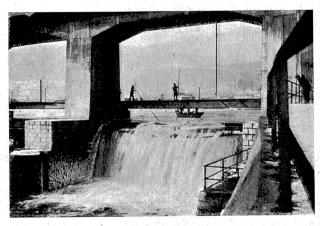
Abb. 21. Elektrizitätswerk Olten-Aarburg, Kraftwerk Gösgen. Abschwemmen der Eisplatten über das Wehr.
