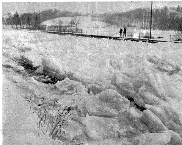
Abb. 5. Elektrizitätswerk Wangen. Packeis beim Fahrhöfli im Oberwasserkanal.
