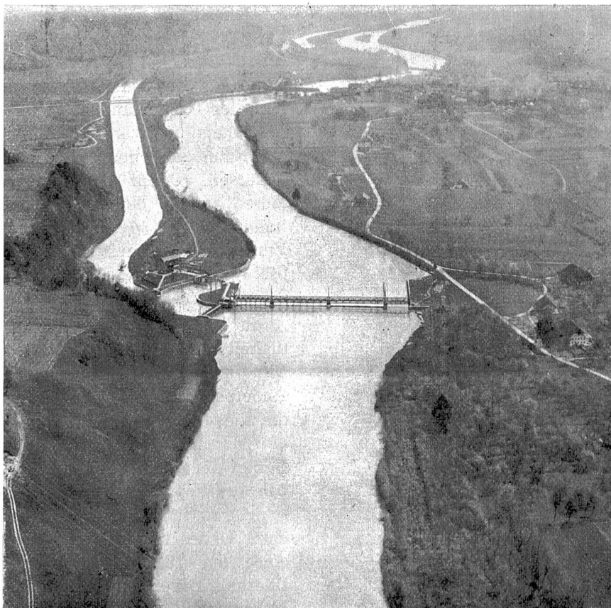
Abb. 2. Elektrizitätswerk Wangen. Wehranlage und Kanaleinlauf.
