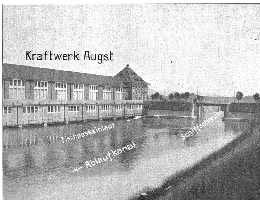
Abb. 1. Eingang zur Schiffschleuse und zum Fischpaß beim Kraftwerk Augst von unten gesehen. Die aus der Schleusenammer austretende Lockströmung fñgt sich annähernd tangential in die Turbinenausläufe und lockt so die vor den Turbinen suchenden Fische zum Einstieg in die Schleusenammer.
