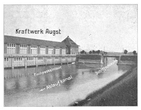
Abb. 1. Eingang zur Schiffschleuse und zum Fischpass beim Kraftwerk Augst von unten gesehen.
