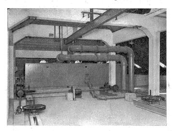
Abb. 9. Hochdruck-Behälter im Dachstock des Nordflügels; rechts Anschluß an den Druckschacht, im Vordergrund die Hubeinrichtung der beweglichen Behälter, oben Laufschiene des Materialaufzugs.
