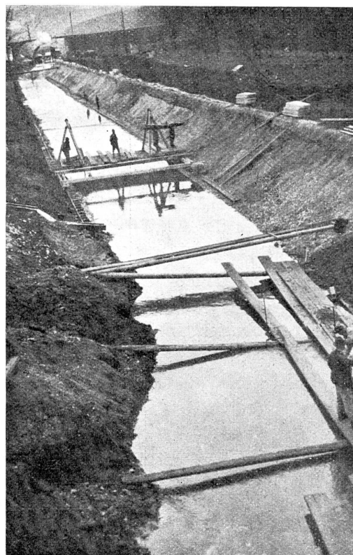
Abb. 2. Rammwagen für die Pfählung.
