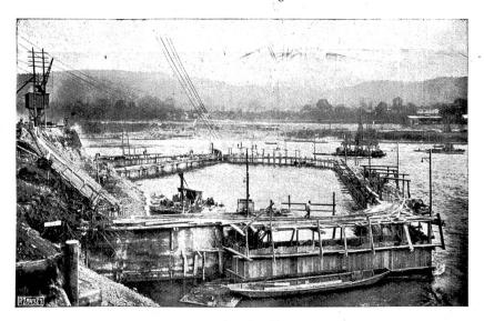
Abb. 3. Blick von Oberstrom auf die Wehrbaugrube am linken Seeufer, Fangdammarbeiten.
