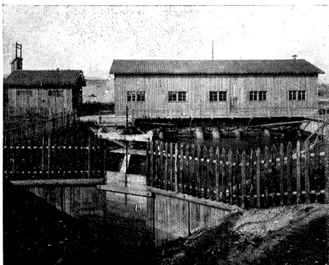
Abb. 19. Pumpwerk Diepoldsau. Ansicht des Klärbassins, der Saugleitungen und des Pumpenhauses von unten.
