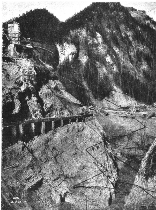
Abb. 3. Kraftwerk Wäggital: Betonrinnen zum Bau der Staumauer.
