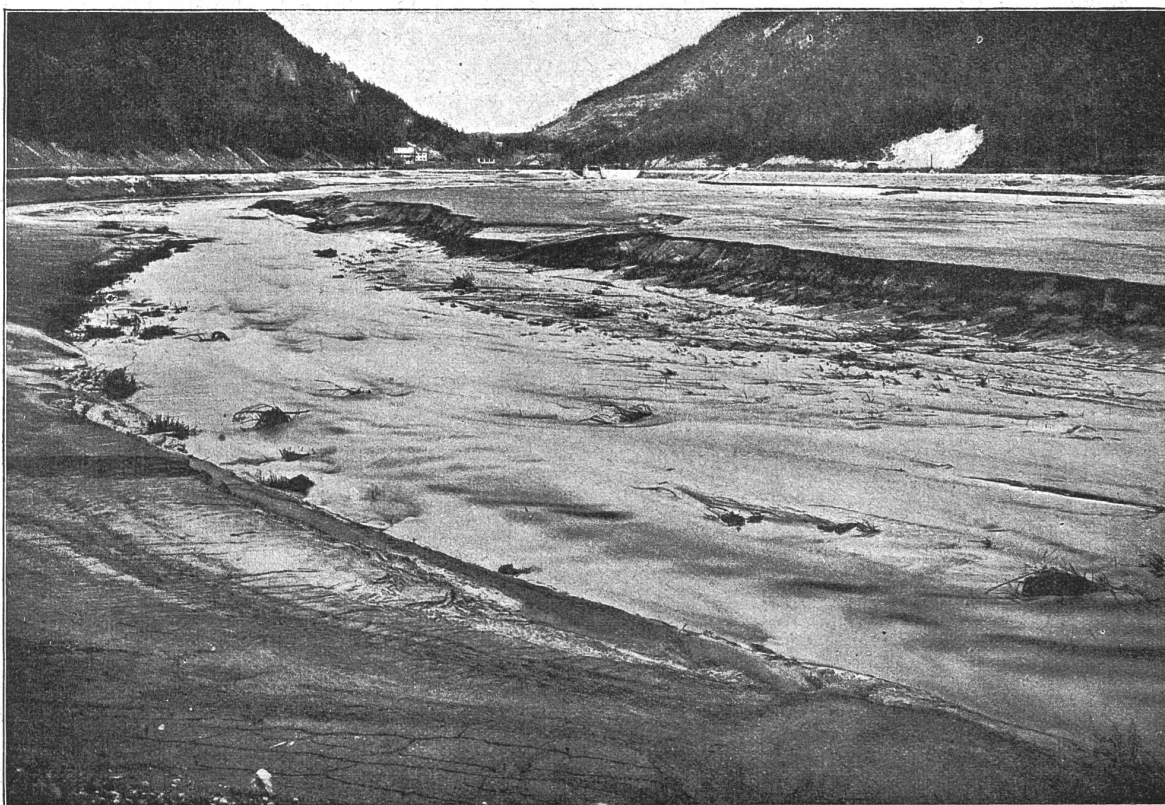
Abb. 2. Saalachsperre bei Reichenhall. Verschlammung und Verkiesung des Speicherbeckens nach 8-jährigem Betrieb.
