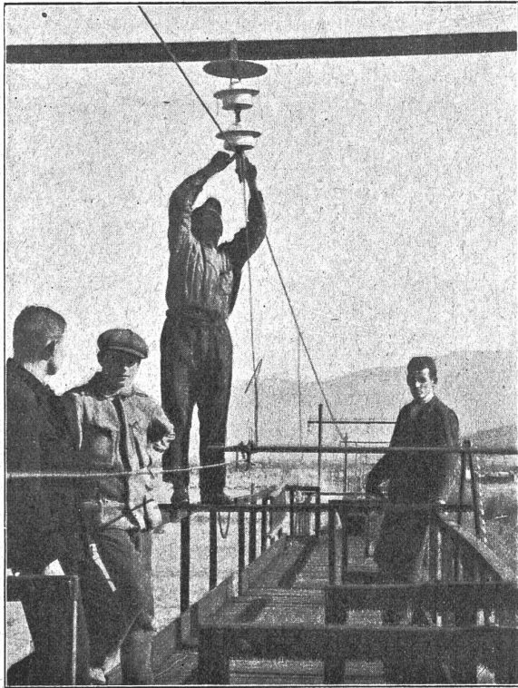
Abb. 17. Montieren der Fahrleitung auf der Strecke Innsbruck-Telfs.
