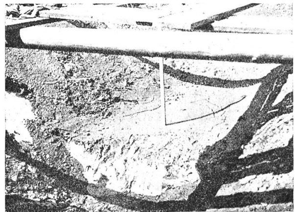
Abb. 3. Lehmabsetzung am Boden des offenen Bassins.
