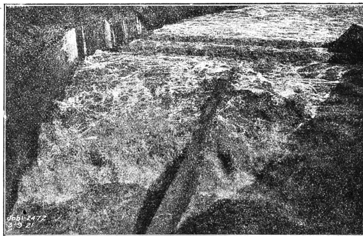
Abb. 14. Bildung der „Stehenden Welle“ im Beruhigungsbecken des Germantown-Dammes während des Hochwassers vom 9. März 1921.
