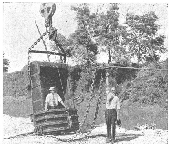
Abb. 12. „Bucket“ zum Materialaushub beim Englewood-Damm, 3,5 \text{ m}^3 Fassungsvermögen.
