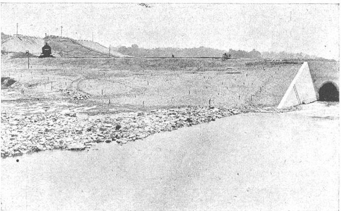
Abb. 10. Englewood-Damm. 8. Juni 1920 Mittelpartie erreicht die Höhen-Kote 245.
