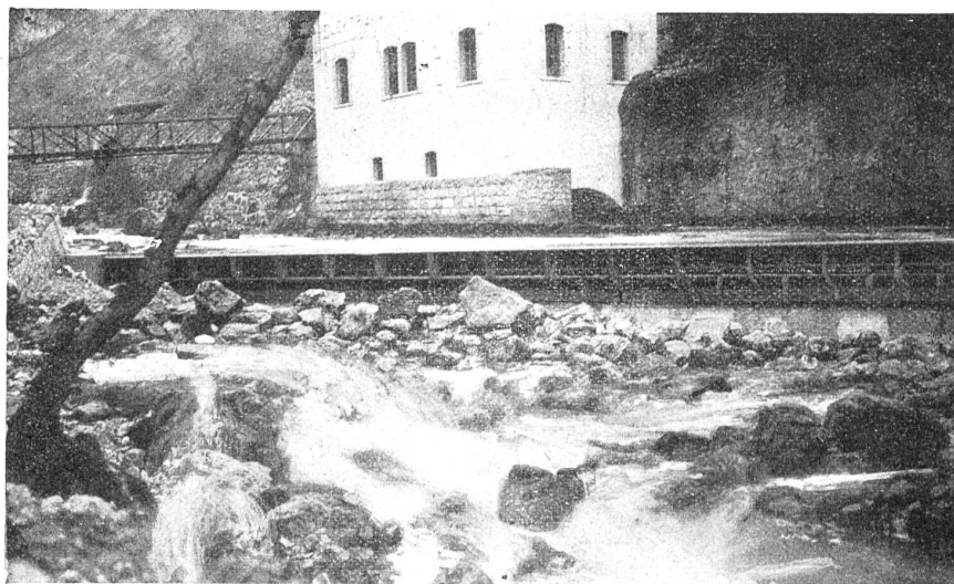
Abb. 14. Selbsttätiges Klappenwehr in der Schüss (Taubenlochschlucht) bei Bözingen.
