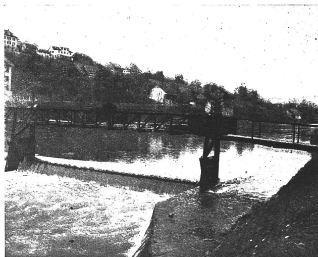
Abb. 78. Wasserkraftanlage der A.-G. Baumann, Höngg. Ansicht des Wehres von unten mit Fischpass am linken Ufer.
