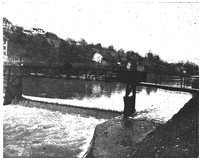
Abb. 78. Wasserkraftanlage der A.-G. Baumann, Höngg. Ansicht des Wehres von unten mit Fischpass am linken Ufer.
