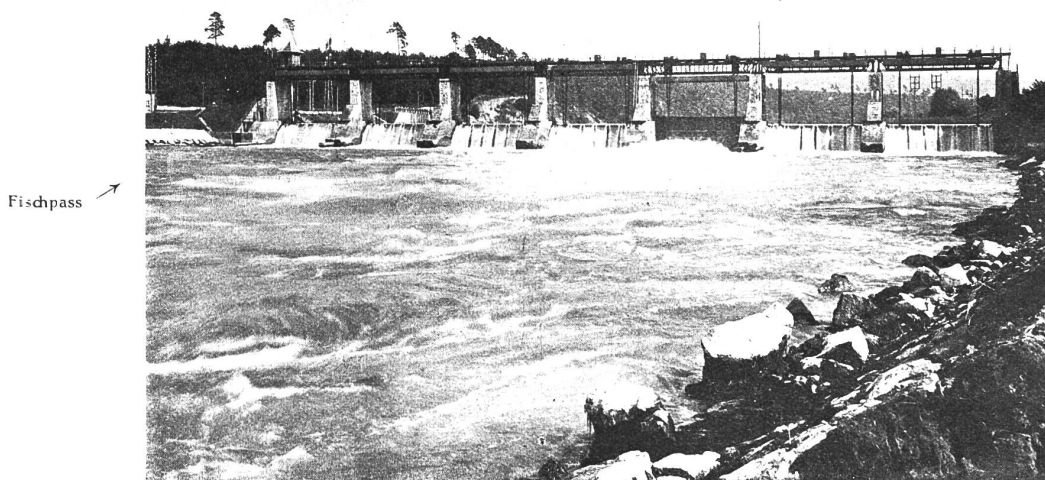
Abb. 54. Elektrizitätswerk Beznau. Ansicht des Stauwehres von unten mit Fischpass auf dem rechten Ufer.
