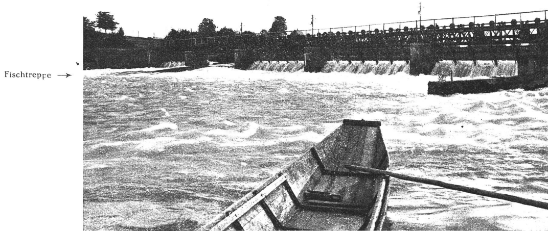
Abb. 43. Elektrizitätswerk Ruppoldingen. Ansicht des Stauwehres von unten mit Fischtreppe auf dem rechten Ufer.
