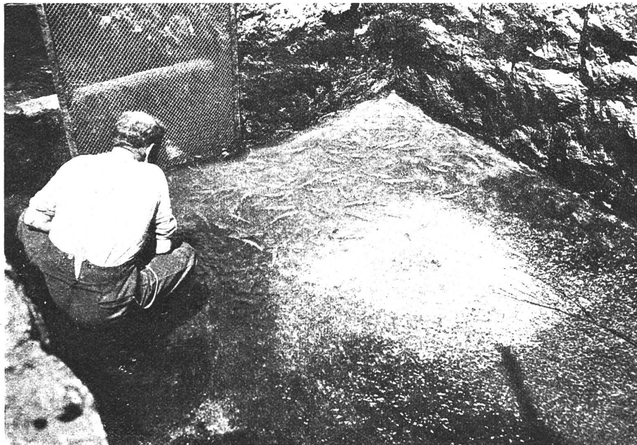
Abb. 40. Stauwehr des Elektrizitätswerks Hagneck. Fische in der zweitobersten Kammer der Fischstiege.
