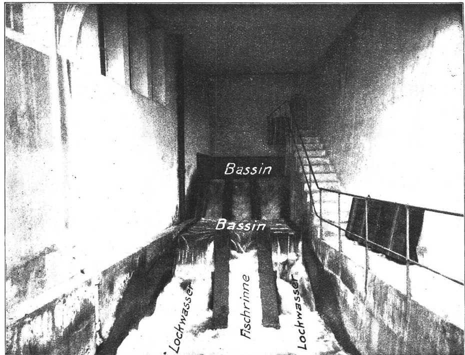
Abb. 15. E.-W. Augst. Unterer Lauf der Deniltreppe.
