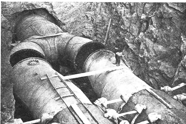
Abb. 17. Verteilungsstück des 4 m Druckstollens auf zwei je 2,80 Rohre. Die Schmetterlingsklappen sind noch nicht montiert.
