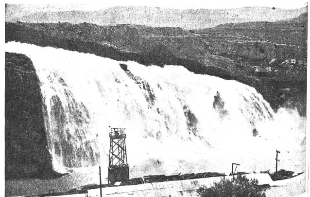
Abb. 4. Blick vom rechten Ufer auf den Hochwasser-Absturz
