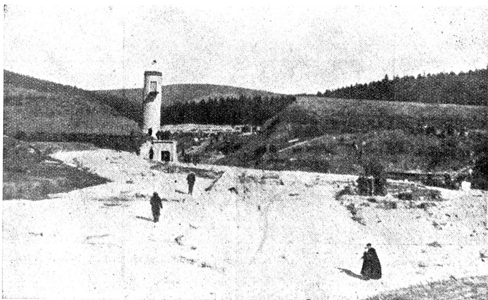
Der Dammbruch an der Weissen Desse. Ansicht des zerstörten Dammes von unten von der rechten Flußseite aus.
