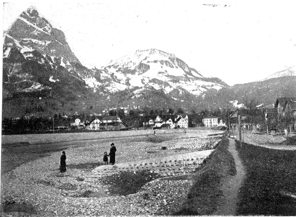
Die Muotakorrektur. Abb. 27. Armierte Betonsporren für Ufersicherung und Verlandung.
