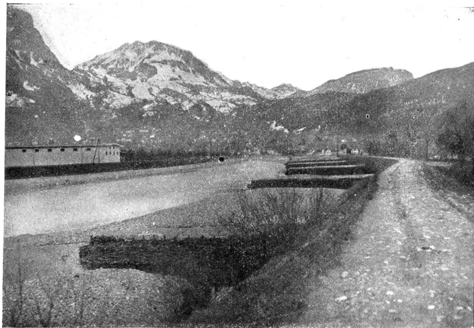
Die Muotakorrektur. Abb. 28. Provisorische Normalisierung des Flusses mit Faschinensporren.
