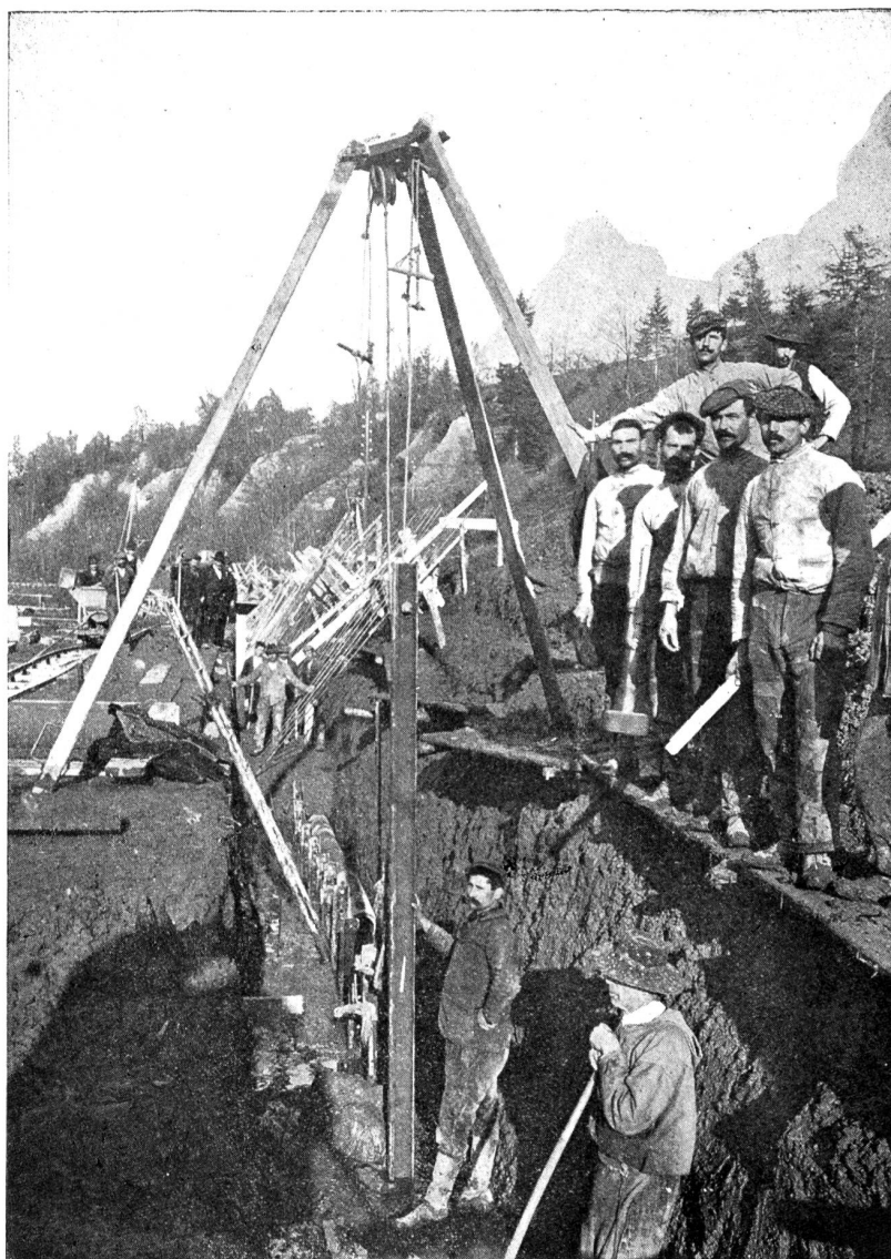
Die Muotakorrection. Abb. 22. Schienenpfähle für die Fundamente der bewehrten Leitwerke.
