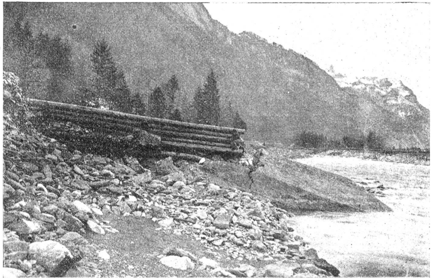
Die Muotakorrektio. Abb. 17. Holzsporren mit Betonkopf.
