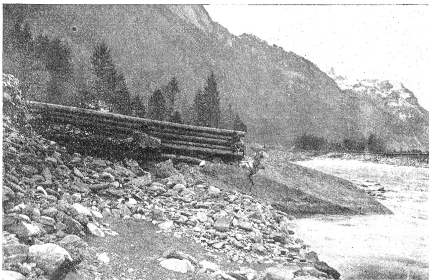
Die Muotakorrekction. Abb. 17. Holzsporren mit Betonkopf.
