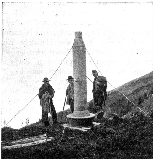
Fig. 1. Vallot-Rohr am Lammbach (1700 m)
