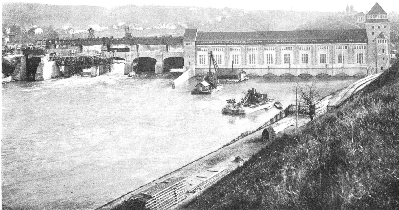
Kraftwerk Laufenburg a. Rh. Stauwehr und Turbinenhaus.
