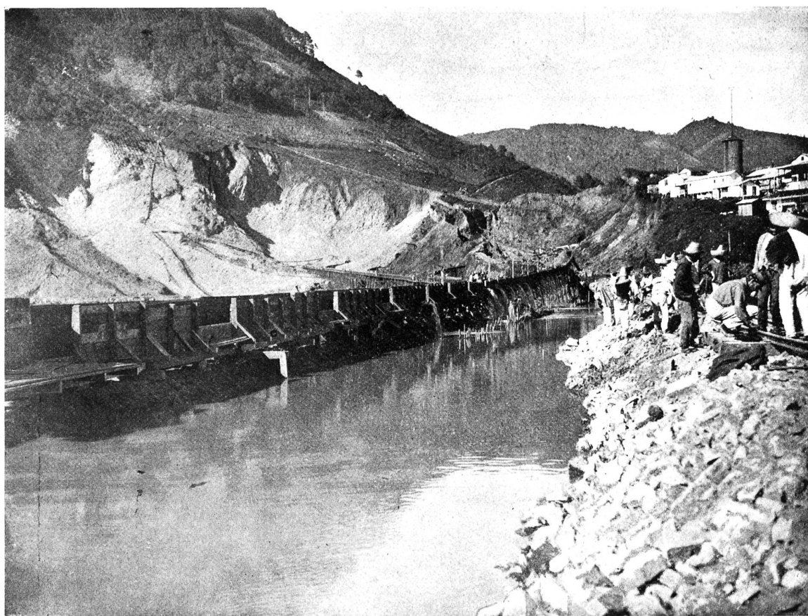
Der Necaxa-Damm. Figur 11. Rechteckiger Kanal zum Einschwemmen des Lehms und der Tepetate.
