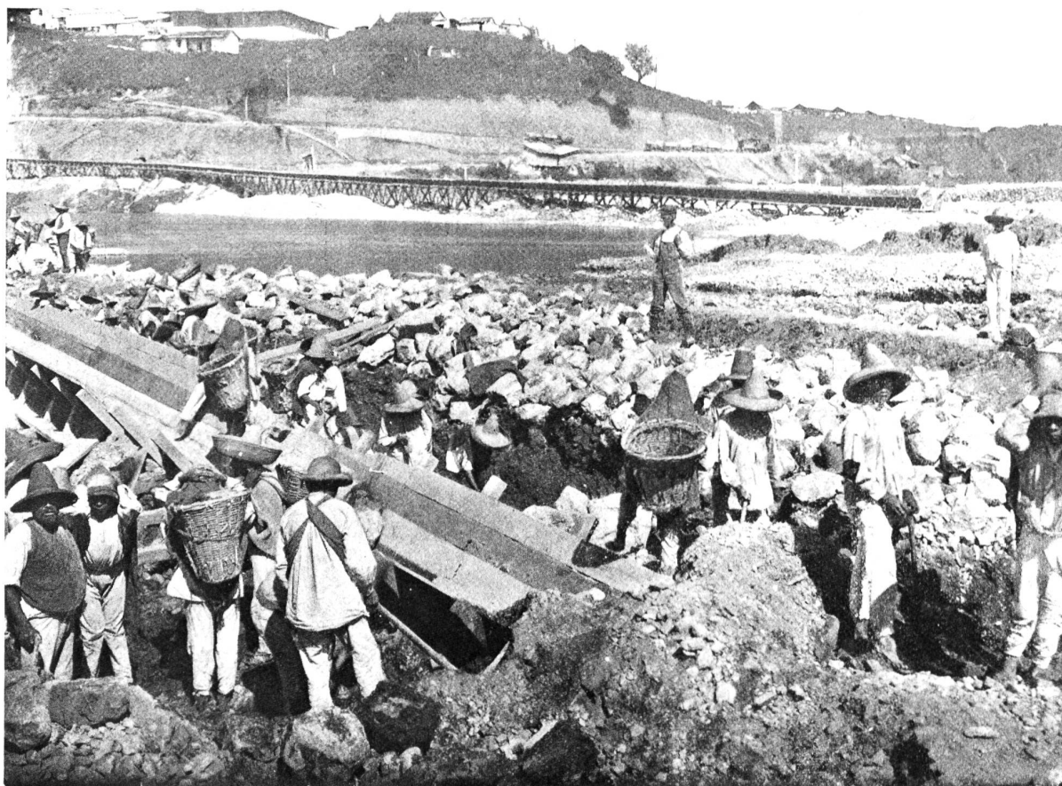
Der Necaxa-Damm. Figur 9. Freilegen einer eingegrabenen Kanalarinne.
