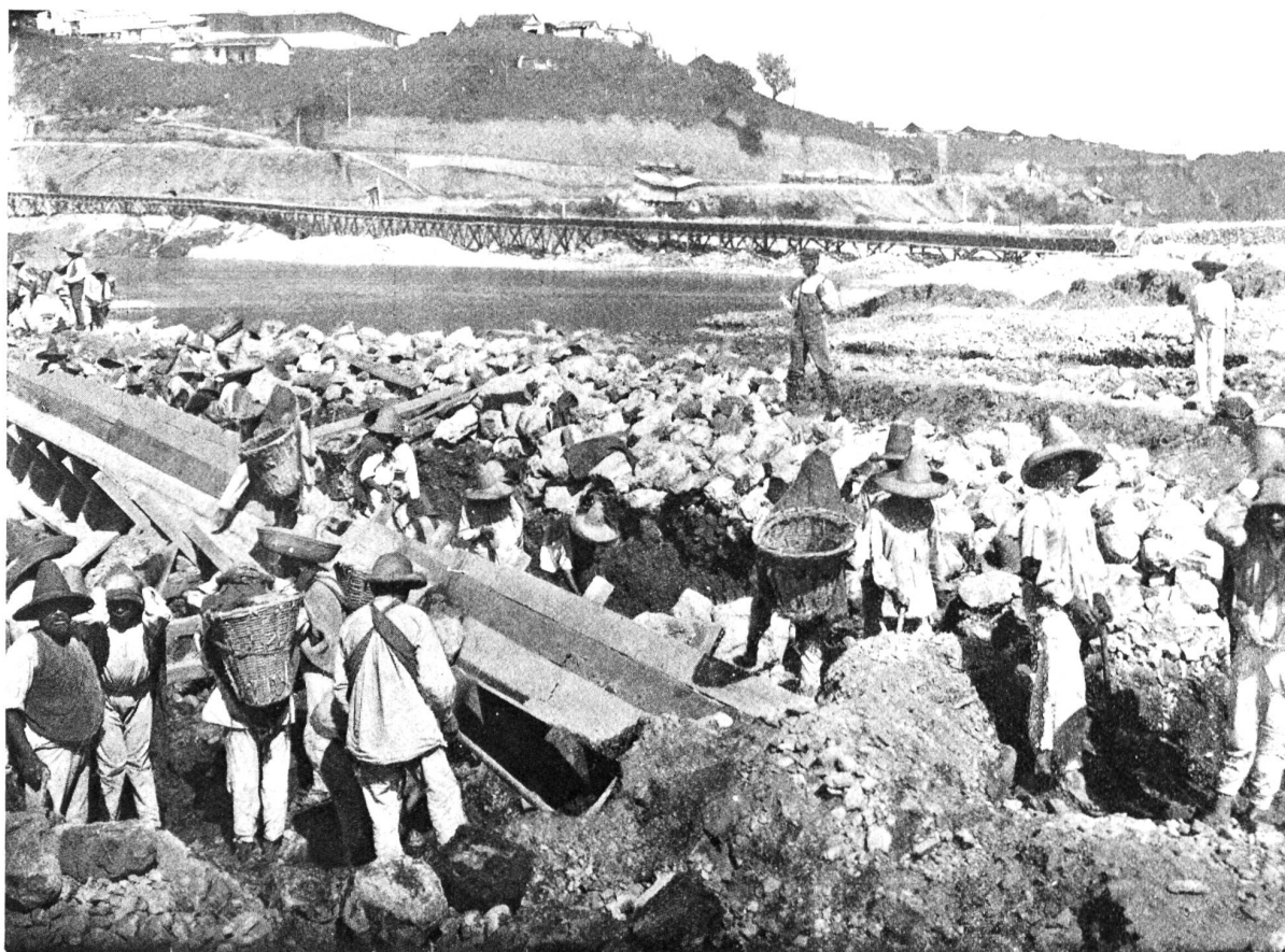
Der Necaxa-Damm. Figur 9. Freilegen einer eingegrabenen Kanalarinne.
