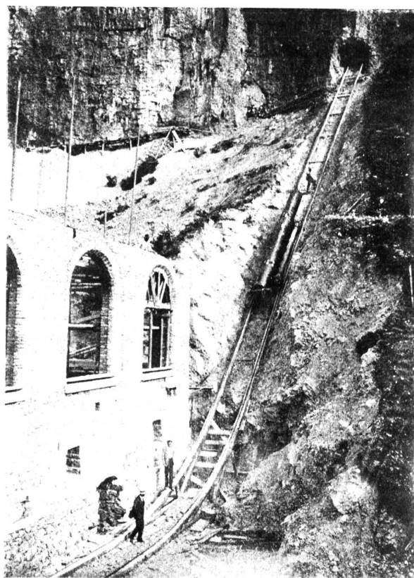
Das Alvierwerk. Abbildung 19. Seilbahn für den Rohrtransport.
