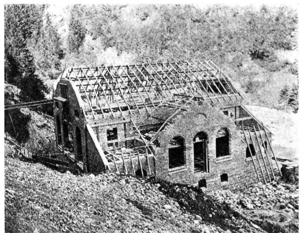
Das Alvierwerk. Abbildung 22. Das Turbinenhaus im Bau.
