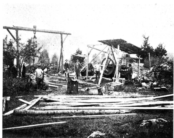
Das Alvierwerk. Abbildung 17. Lokomobil und Winde der Seilbahn zum Rohrtransport.
