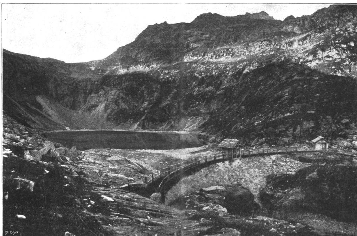
Abbildung 3. Chironico-See mit Stauanlage.
